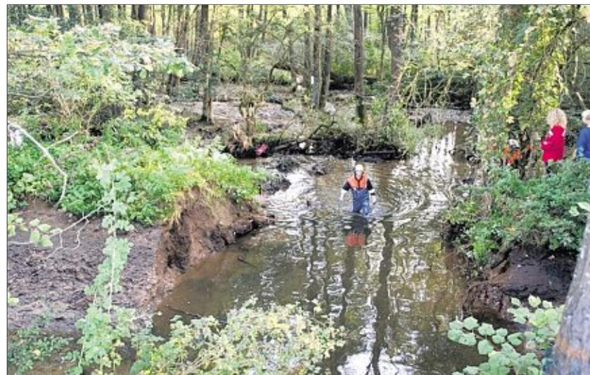
Auf einer Länge von sieben bis acht Metern ist der Damm des Flutkanals zwischen Troschelhammer und Dießfurt gebrochen. Bilder: is (2)
