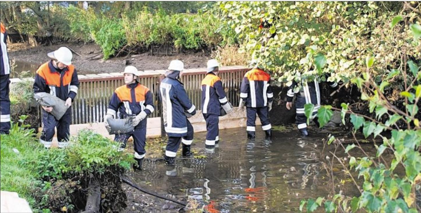
Die Dießfurter Feuerwehr verhin- derte durch das Stapeln von Sandsä- cken, dass der Hammerweiher voll- ständig auslief. Mit im Einsatz war zeitweise auch die Pressather Wehr. Ursache war vermutlich ein Biber, der den Damm unterhöhlt hat.
